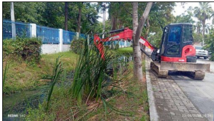
รูปที่ 2-22 กิจกรรมขุดลอกระบบท่อ / รางระบายน้ำเสีย
