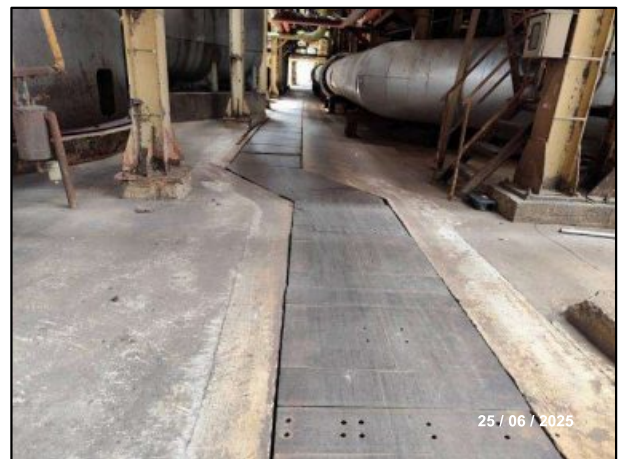
รางรวบรวมน้ำฝนปนเปื้อน
