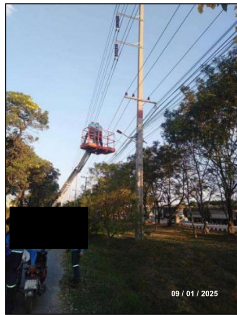
รูปที่ 2-63 การตรวจสอบ ทำความสะอาดหลอดไฟ
