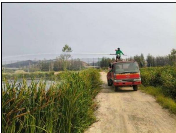
รูปที่ 2-9 การเติมปูนขาวในบ่อพักน้ำเสียโครงการ
