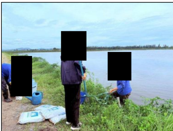
รูปที่ 2-11 การเติมจุลินทรีย์ในบ่อบำบัดน้ำเสีย
